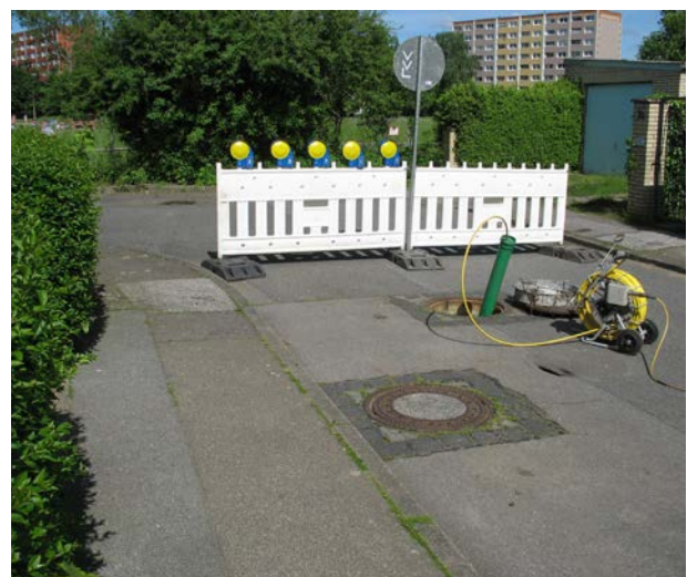
Abbildung 8: Einsatz eines Kanalfernauges (KFA) (Quelle: Hamburger Stadtentwässerung AÖR)
